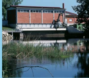
Schöpfwerk Philippsburg beim Rückhalteraum Rheinschanzinsel
