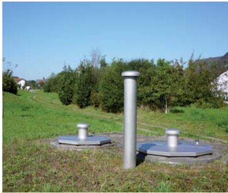
Brunnengalerie in Kehl-Marlen. Außensicht
