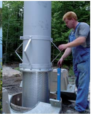
Herstellung eines Schutzbrunnens
