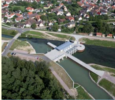
Acherschöpfwerk im Rückhalteraum Söllingen/Greffern
