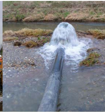
Ableitung des geförderten Grundwassers beim Pumpversuch
