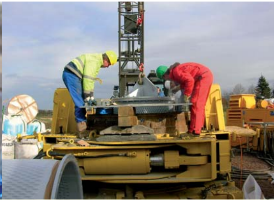
Einbau eines Brunnenrohrs in den Brunnen-schacht
