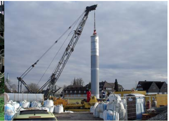
Einbau eines Brunnenrohrs in den Brunnenschacht
